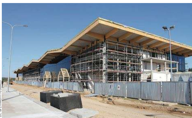
Budowa hali na lotnisku w Szymanach
