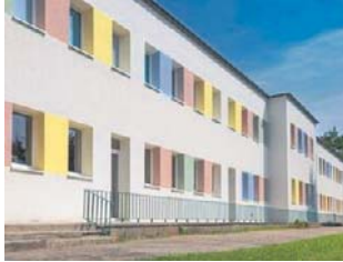
Termomodernizacja żłobka i przedszkola
