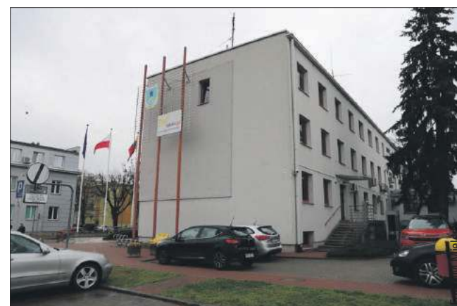
Teraz do UM będzie można wejść bocznymi drzwiami od strony parkingu.
