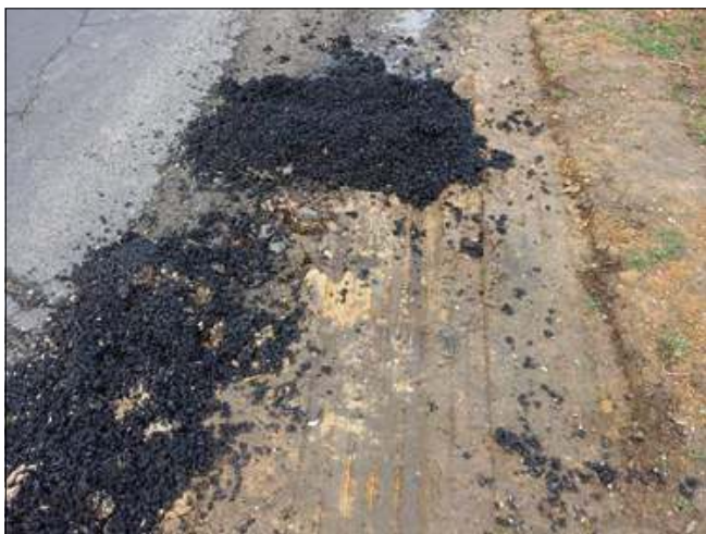
Masa asfaltowa rozrzuca jest łopatą, a efekt? Jak na załączonej fotografii (Rogów Opolski).
