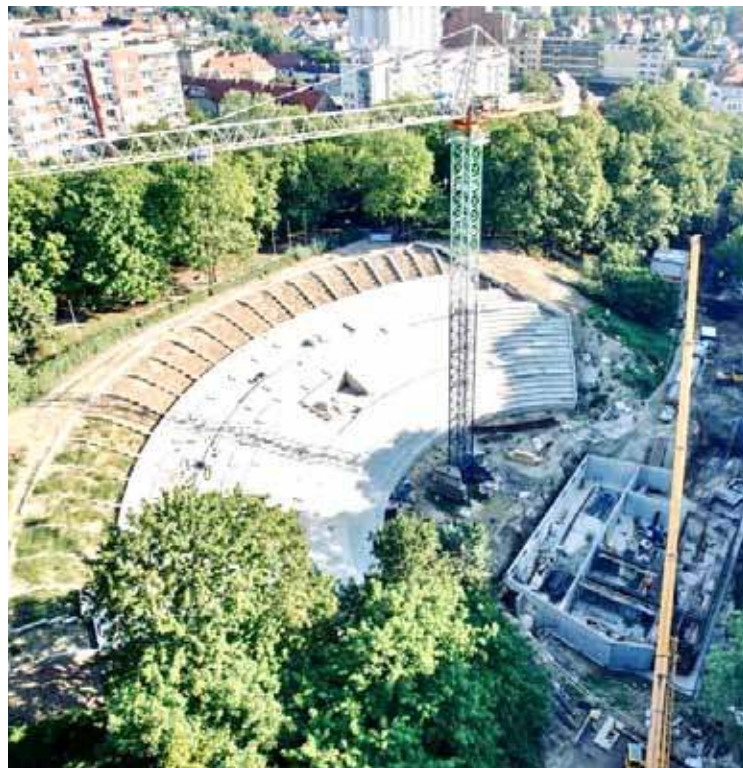
Przebudowa amfiteatru będzie jedną z większych inwestycji, którą miasto planuje zakończyć w 2024 roku.
