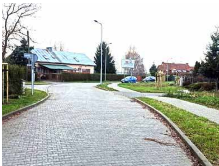
Nowa jezdnia i trasa dla pieszych są już w użytku
