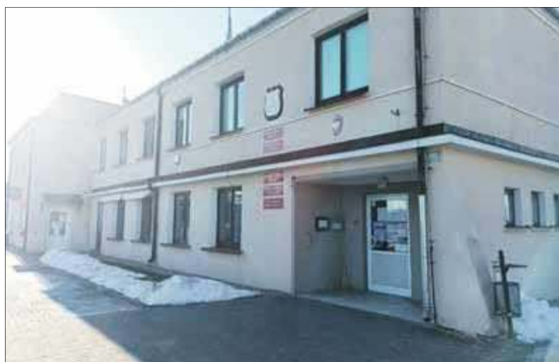
Budynek urzędu gminy w Tucznym niebawem przejdzie gruntowną modernizację. Inwestycja wpłynie też na poprawę efektywności energetycznej
