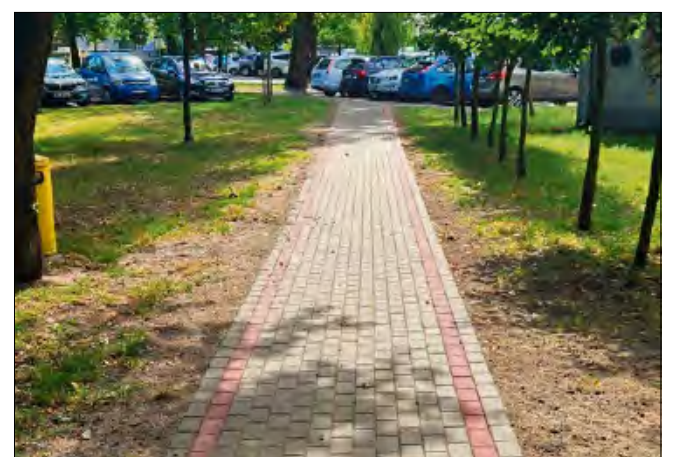
Fragmenty nowych chodników pojawiły się w Ozimku oraz Schodni.
