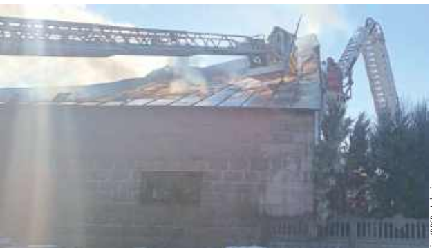
Prawdopodobną przyczyną pożaru było zwarcie instalacji elektrycznej
