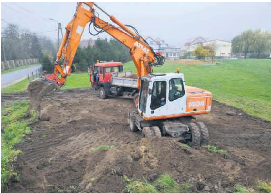
W ubiegłym tygodniu ruszyły prace ziemne związane z gazyfikacją Przeworna
