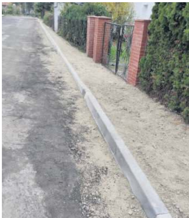
Zakres prac obejmuje między innymi ułożenie krawężników wzdłuż drogi
