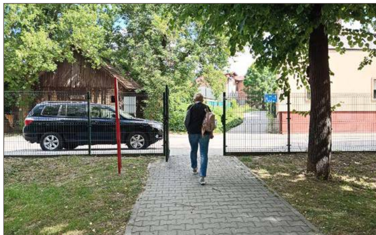
Od strony Żeromskiego zamontowana została furtka, która wraz z innymi wejściami do parku będzie zamykana na noc.
