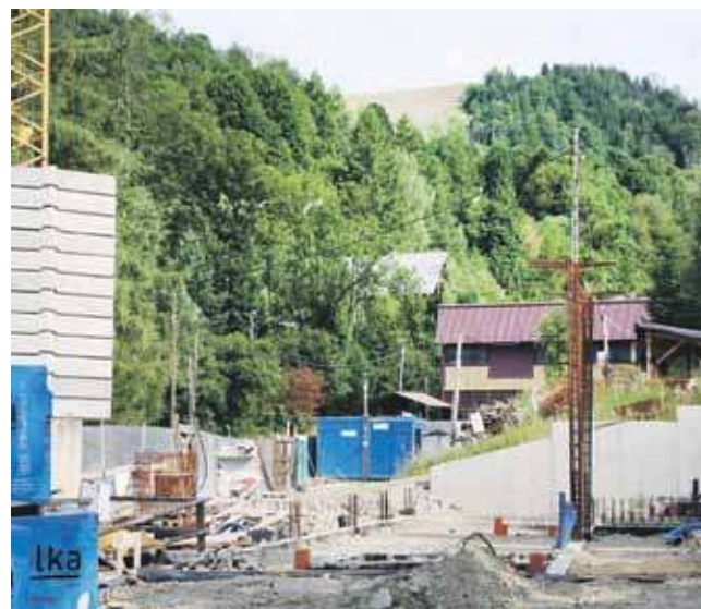
Według ostatnich informacji budowa komisariatu w Szczawnicy ma się zakończyć w pierwszej połowie 2020 roku.
