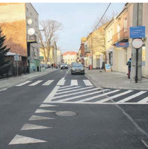
Paderewskiego w Nisku po modernizacji
