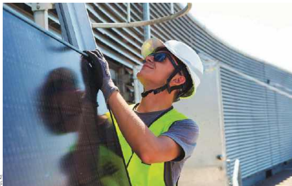
Instalacja paneli słonecznych na budynku Berlaymont, Bruksela
