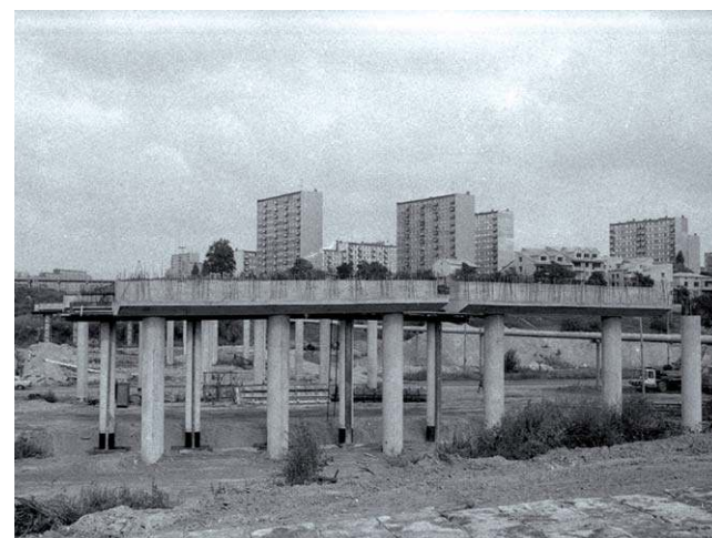
Budowa wiaduktu nad ulicą Filaretów
