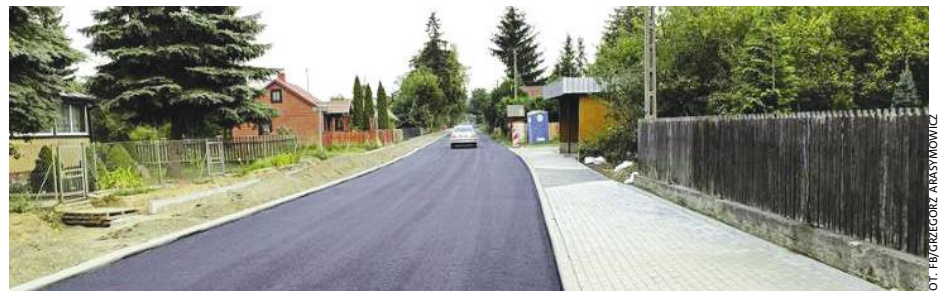
Dzięki współpracy gminy i powiatu wyremontowano 10-kilometrowy odcinek drogi.
