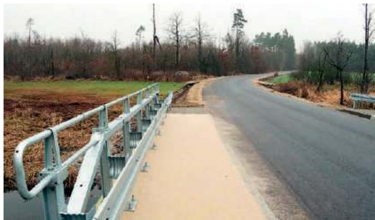
Nowy most oraz przebudowana droga powiatowa nr 3421W Obryte-Pniewo-Zatory w miejscowości Mystkówiec Kalinówka
