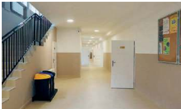
Modernizacja budynku ZSZ im. J. Ruskowskiego w Pułtuskim - szkolny korytarz po modernizacji
