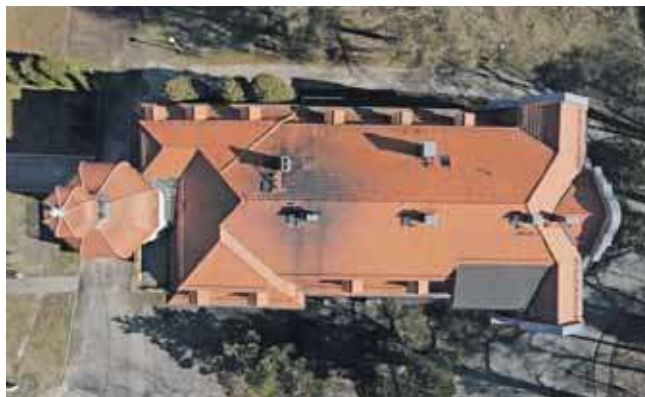
Pałac w Kopaninie, przysiółku Miedar, wybudowano pod koniec XIX wieku, rozbudowano na początku XX wieku. Wzniesiona na planie prostokąta, jednopiętrowa budowla, jest przykryta dachem mansardowym z lukarnami. Po stronie północnej znajduje się wieża zwieńczona baniastym hełmem. Bryłę budynku urozmaicają ryzality z barokowymi szczytami
