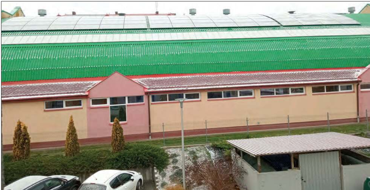
➤ Jednym z budynków użyteczności publicznej, jaki już został wyposażony w instalacje OZE, jest hala sportowa w Kłoczewie
