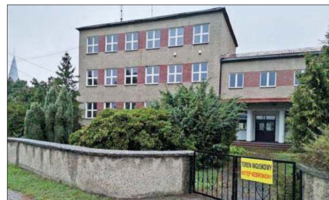
Budynek dawnej szkoły przy ul. Arki Bożka w Kuźni Raciborskiej. Choć przejęty przez wojsko dwa lata temu, to wciąż stoi pusty. Miał być koszarami kolejnego batalionu lekkiej piechoty. Teraz wojsko ma na niego inny pomysł.
