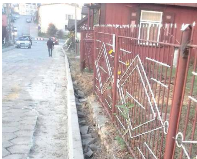
Stoczkowianie mieszkający przy ul. Szkolnej cieszą się, że ich ulica jest wreszcie remontowana. Niestety martwią się o miejsce na chodnik, gdyż ich bramy od krawężnika powstającej drogi dzieli tylko bardzo wąski odstęp
