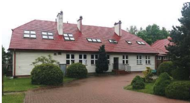
Przedszkole w Modlinie Starym przejdzie termomodernizację
