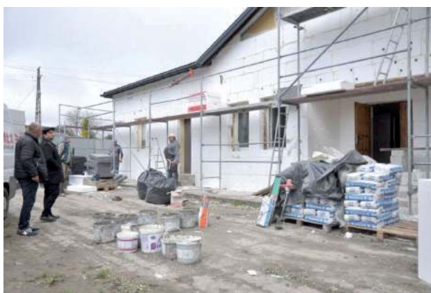
Trwają prace związane z modernizacją budynku świetlicy wiejskiej w Kłodnicy. Budowlancy docieplają ściany zewnętrzne
