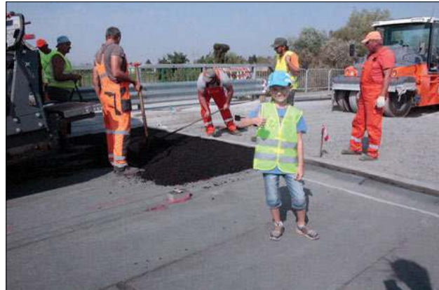
Pytamy Krzysia, co tu robi? – Buduję most i patrzę, jak maszyny pracują – mówi 8-latek
