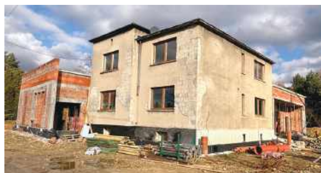
■ Nowa siedziba w budowie
