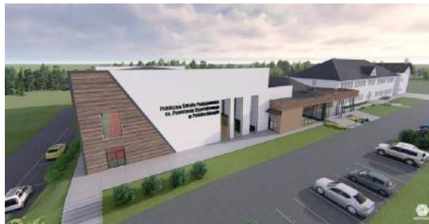
Nowa hala sportowa w Potoku Górnym ma być gotowa w październiku przyszłego roku
