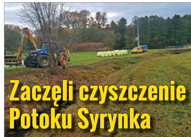
Prace prowadzone są równolegle na odcinku w Pszowie oraz w Zawadzie przy ul. Szybowej (na zdj.)
