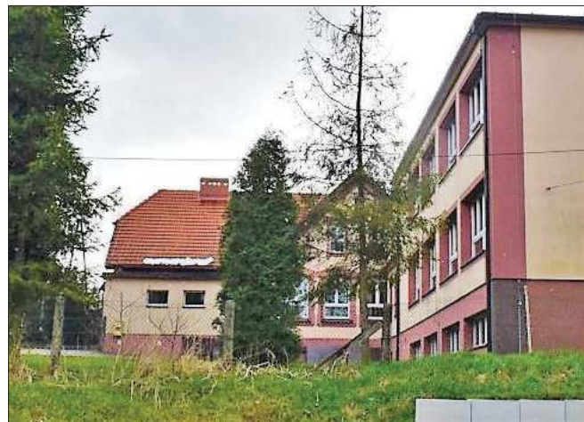
Sala gimnastyczna zostanie wybudowana z tyłu szkoły
