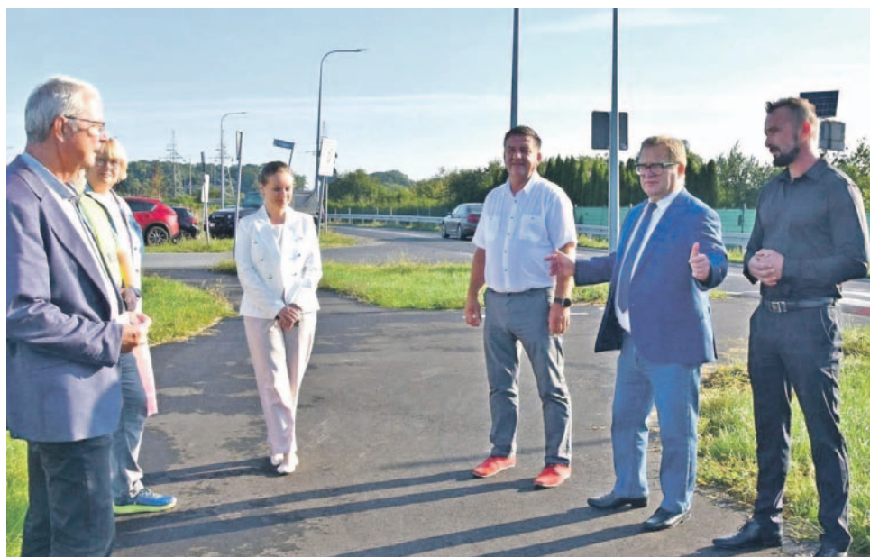
W ramach zakończonej inwestycji powstał nowy odcinek drogi dla pieszych i rowerów przy ul. Kilińskiego w Oławie. Ścieżka ma nawierzchnię bitumiczną i została wyposażona w oświetlenie
