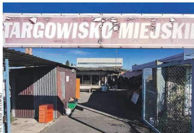
Wejście na targowisko miejskie od strony parkingu przy Krakowskiej w Chrzanowie
