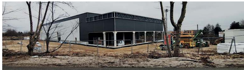
Budowa hali firmy Blachy Pruszyński
