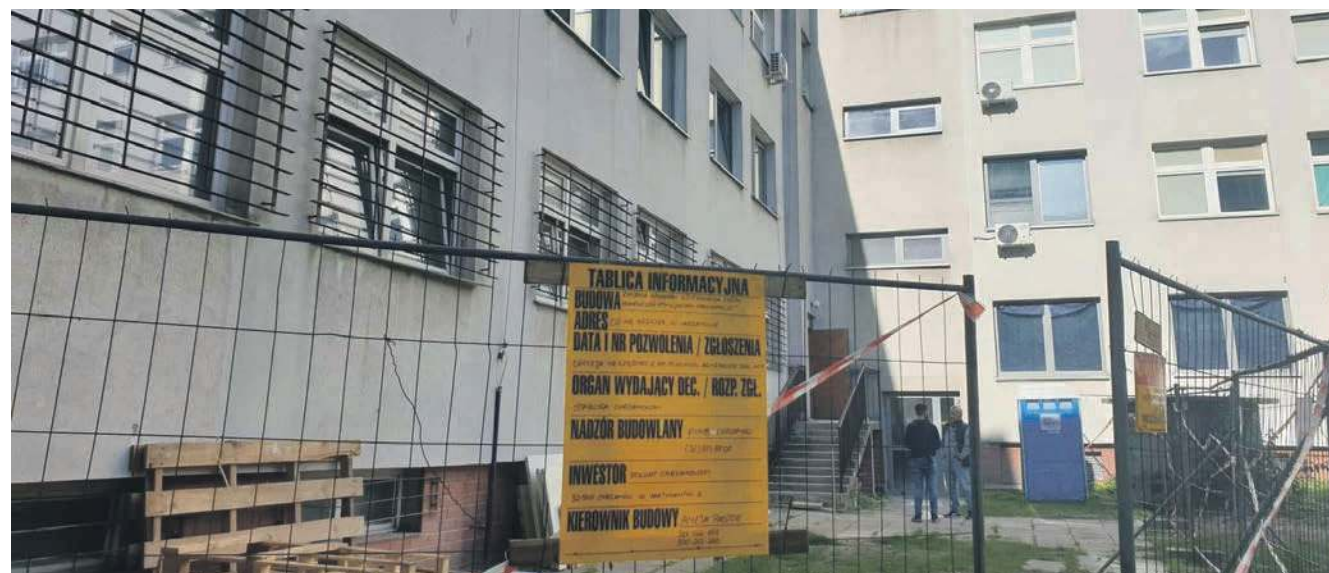
Pomieszczenia w budynku C szpitala zajmie wkrótce PCPR
