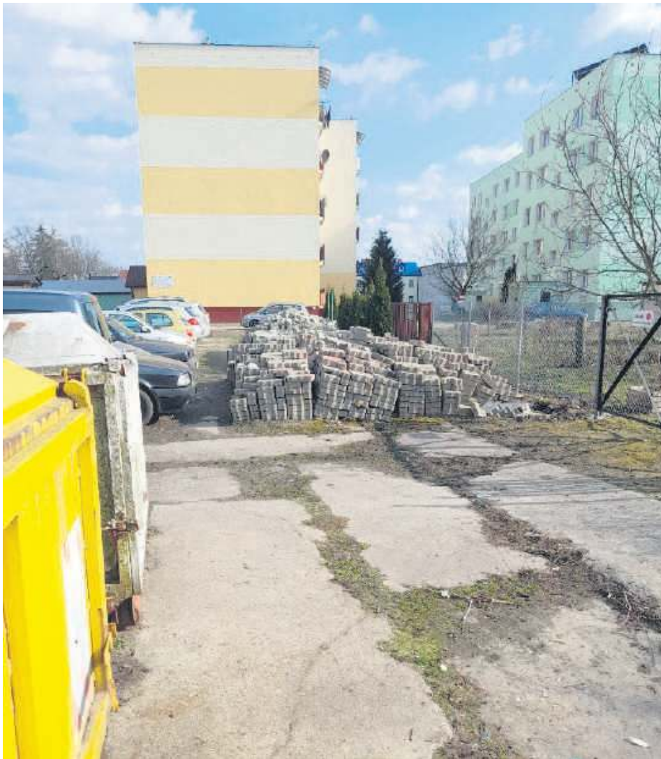
Mieszkańcy bloku przy ul. Szkolnej 3 zapewniają, że kostka do wymiany płyt na parkingu osiedlowym już od co najmniej 2-3 lat leży spakowana i niszczeje.
