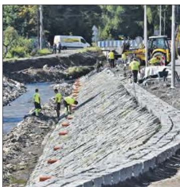
Prace na Złotym Potoku w Jarnońtówku
