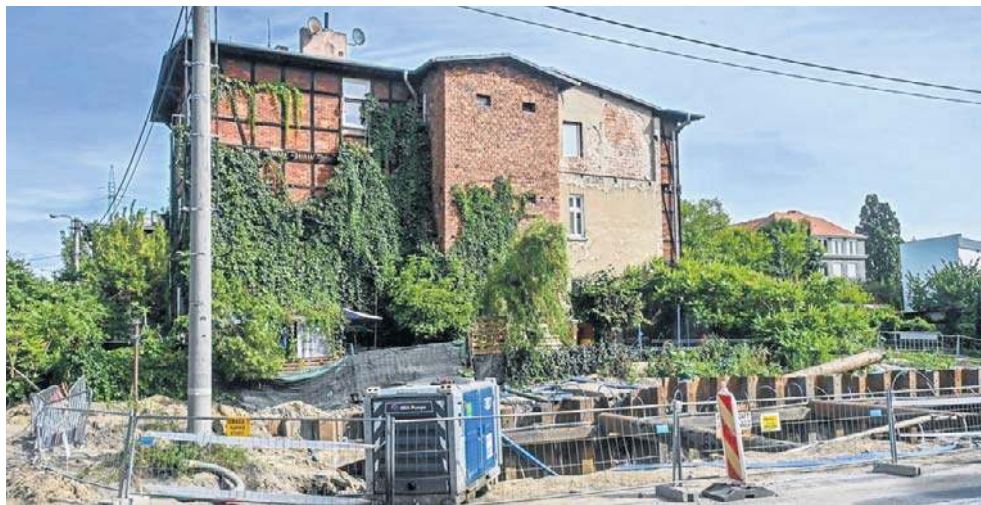
Jedna z rodzin z budynku przy Pomorskiej ma już nowy adres zamieszkania
