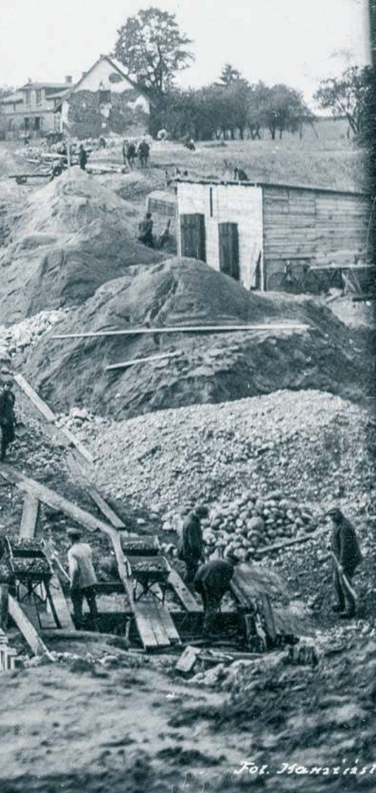
Budowa linii kolejowej Bydgoszcz–Gdynia, wiadukt na odcinku Żukowo–Osowa, 11 października 1928 r.
