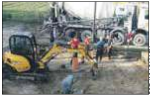
Koszt przebudowy oczyszczalni ścieków to 1,6 mln zł
