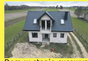
Dom w stanie surowym otwartym, Wólka Siemieńska, 885 851 160
