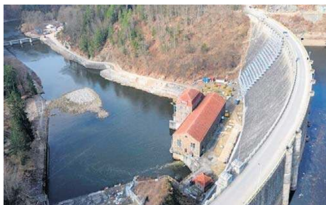
Remont Zapory Pilchowice. Właśnie zamknięto dla pojazdów drogę po jej szczycie. Wciąż jest otwarta dla pieszych
