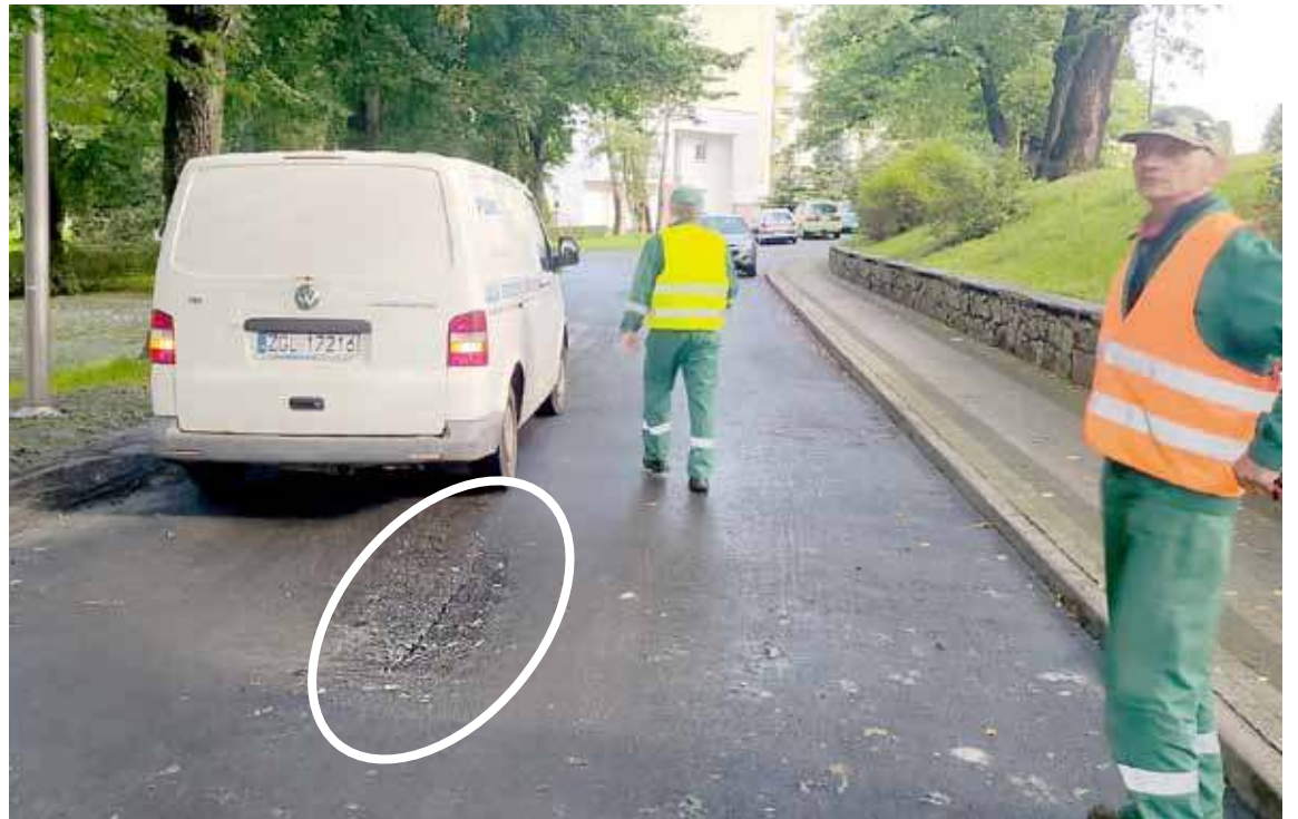
Na miejscu, przed godz. 9 przybyli pracownicy PUWiSu
