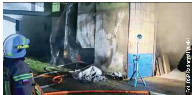
Nocna interwencja służb. Ogień w zakładzie produkcyjnym.
