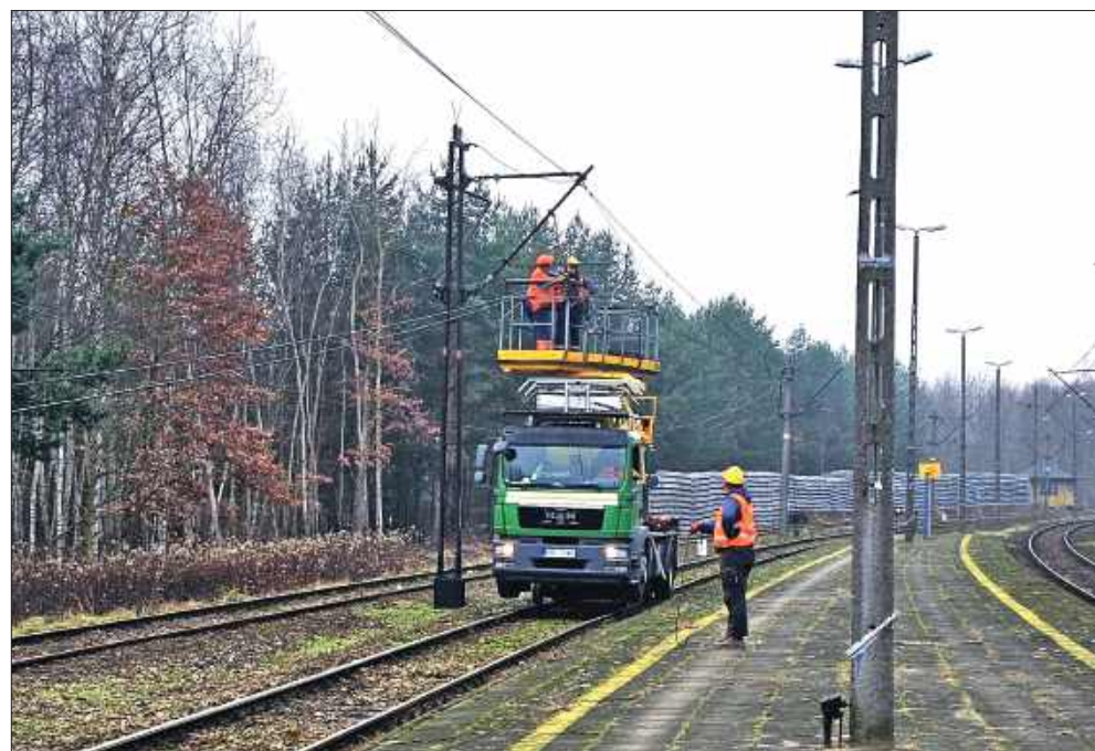
Demontaż sieci trakcyjnej w stacji Sobów.
