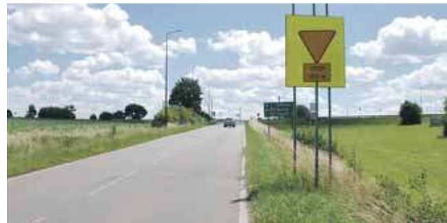
Rozpoczęła się przebudowa drogi krajowej nr 94 i już są problemy FOT. ALICJA JURASZ
