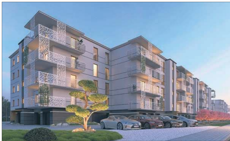
Osiedle ZEN powstaje przy ul. Urodzajnej w Płocku
