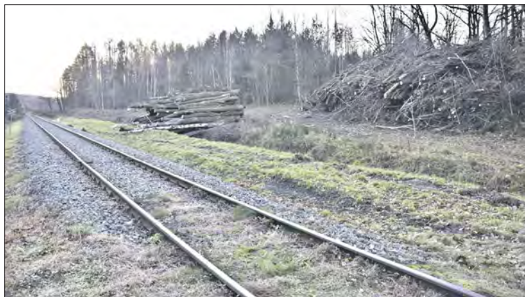
Akcja Kolei objęła również linię używaną przez Czechów między Wieszczyzną a Głucholazami. Na fotografii oczyszczony pas 15 metrów przy linii obok szosy Wieszczyzna - Pokrzywna
