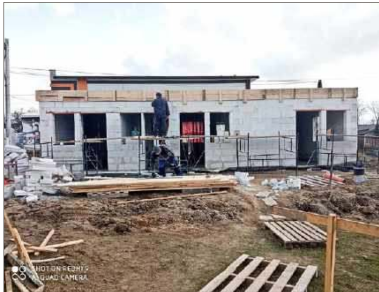
Budowa pomieszczeń dla sportowców w Wiewiórcie.
