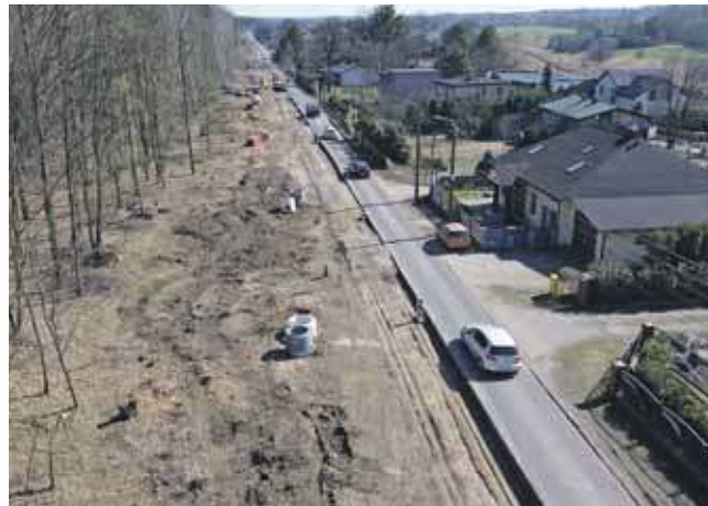
Przebudowa będzie kosztować ponad 14,6 mln zł
