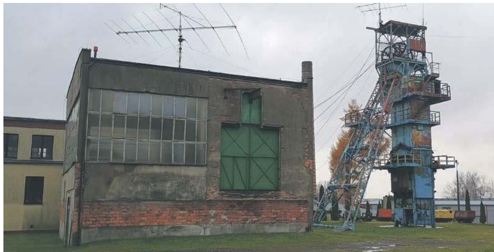
15-metrowa wieża wyciągowa na Zbyszku, jedna z nielicznych architektonicznych pamiątek po kopalni
