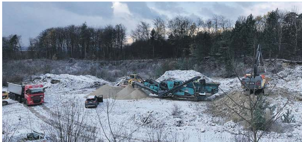
Ciężki sprzęt pracujący w kamieniołomie w Mirowie. Zdjęcie przysłane przez mieszkańca tej wsi
