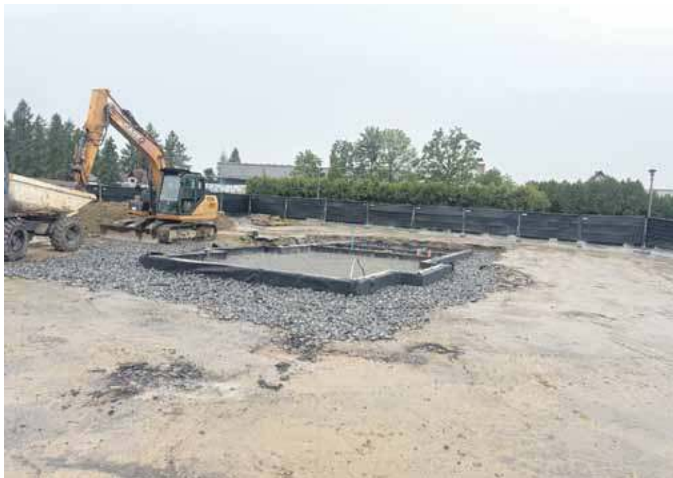
Fundamenty nowej kaplicy cmentarnej na Zaborni.
