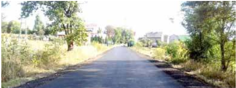
Zakończyła się przebudowa drogi między miejscowościami Szadzko i Dobrzany
