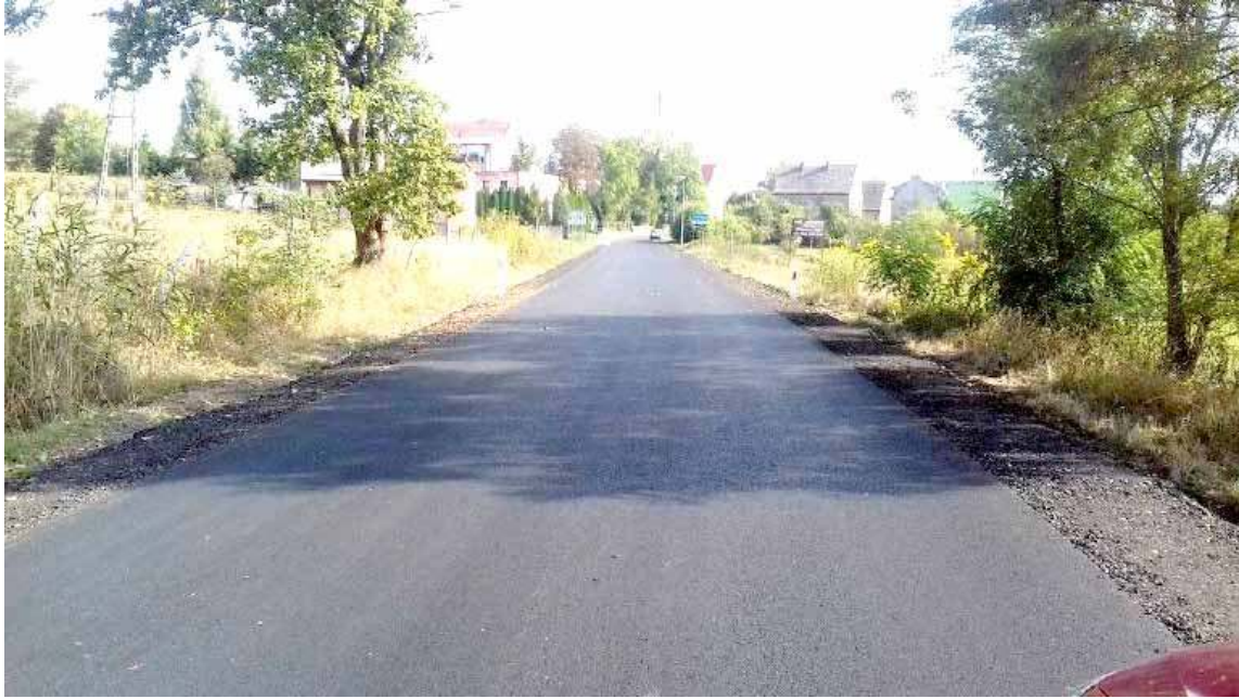
Zakończyła się przebudowa drogi między miejscowościami Szadzko i Dobrzany
