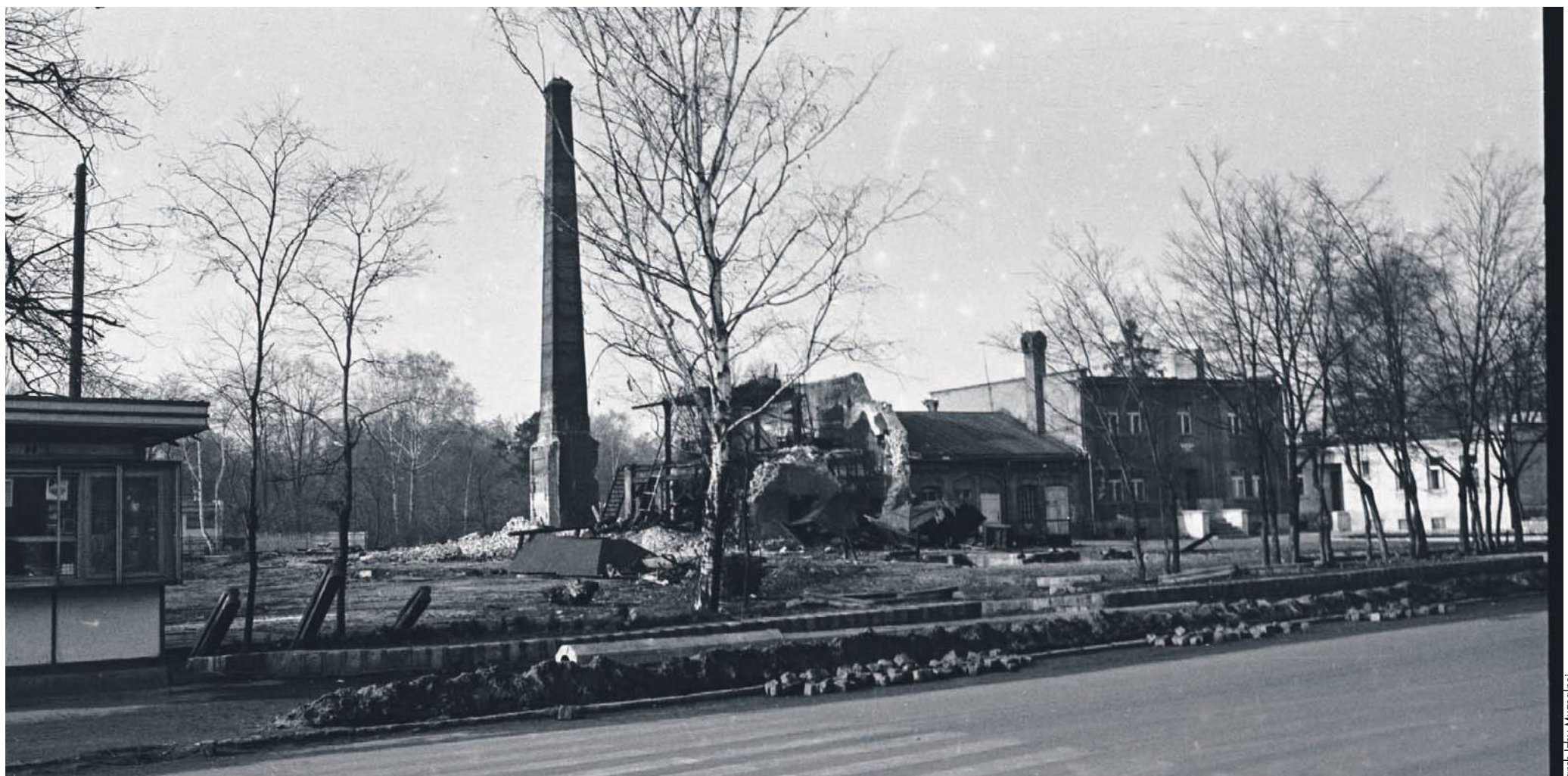
Oława. Przełom 60. i 70. Komin gazowni jeszcze stoi, ale budynki właśnie są burzone
