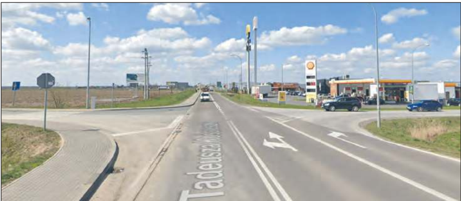
» - Usprawnienie organizacji ruchu na skrzyżowaniu ze strefą gospodarczą przy Shellu, ale przede wszystkim poprawa bezpieczeństwa w tym miejscu, to jedno z największych wyzwań w najbliższym czasie - mówi Marzena Świeczak , burmistrz Garwolina
