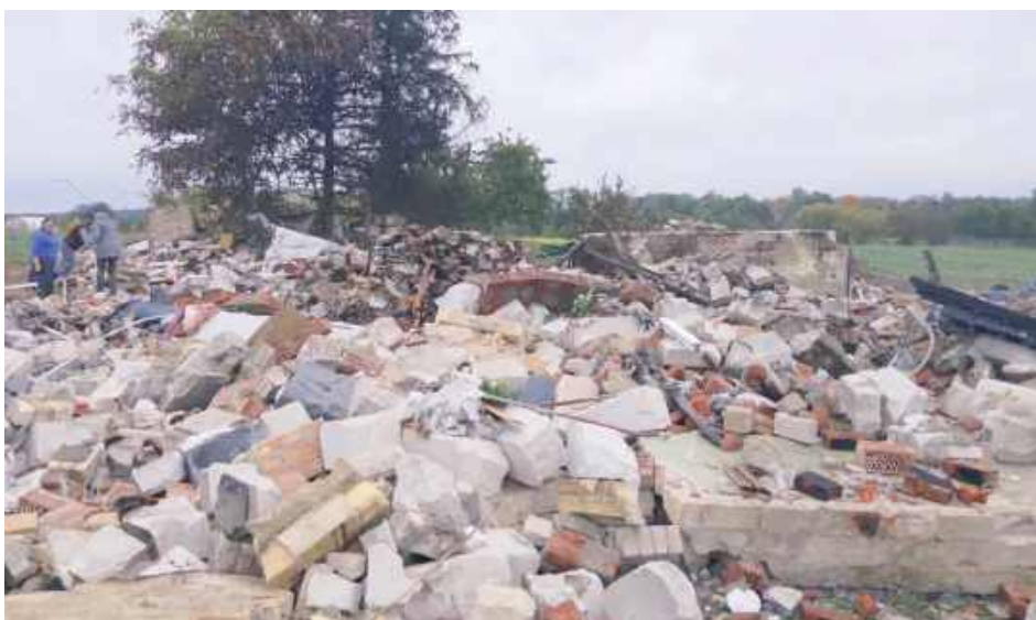
- To, co zobaczyliśmy, zmroziło nam krew w żyłach. Kupa gruzu i leżący na nich dach. To wszystko, co zostało - mówi Marcin
